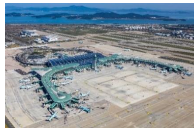
▲仁川国際空港第2ターミナル（外観）
