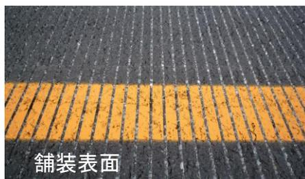
※配合については、空港基本施設の表層材として採用している改質アスファルトと同仕様で施工しております。
