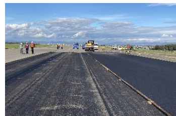
旭川空港／誘導路改良工事
