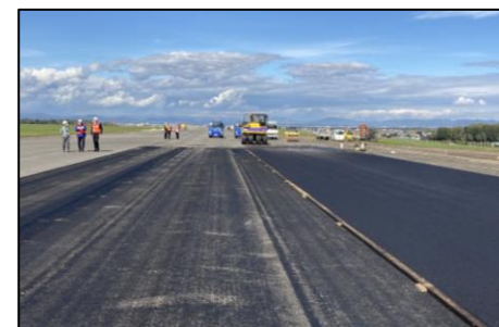
▲旭川空港／誘導路改良工事 参考写真
